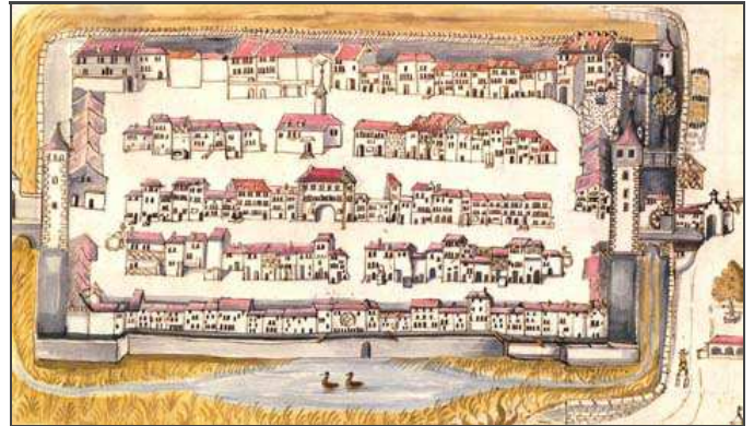
Institut für Denkmalpflege der ETH Zürich (Hg.) - Stadt- und Landmauern, Bd. 2: Stadtmauern in der Schweiz | Kataloge, Darstellungen | Zürich, 1996 | S. 229
